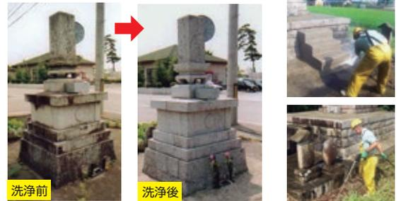
現地にて、高圧洗浄機で水洗いし、石材専用洗剤にて洗浄いたします。特殊電動ブラシで水垢・コケ等のこびりついた汚れを落とします。最後に高圧洗浄機で水洗いをして完了です。完成後は、くすみが取れリフレッシュします。
